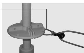
固定パイプ側のディスクプレートに、滑車に付いているフックを取り付けます。
